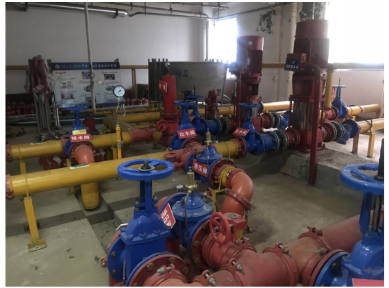
消防栓泵水系统改造
